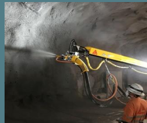
Püskürtme Beton Uygulaması
